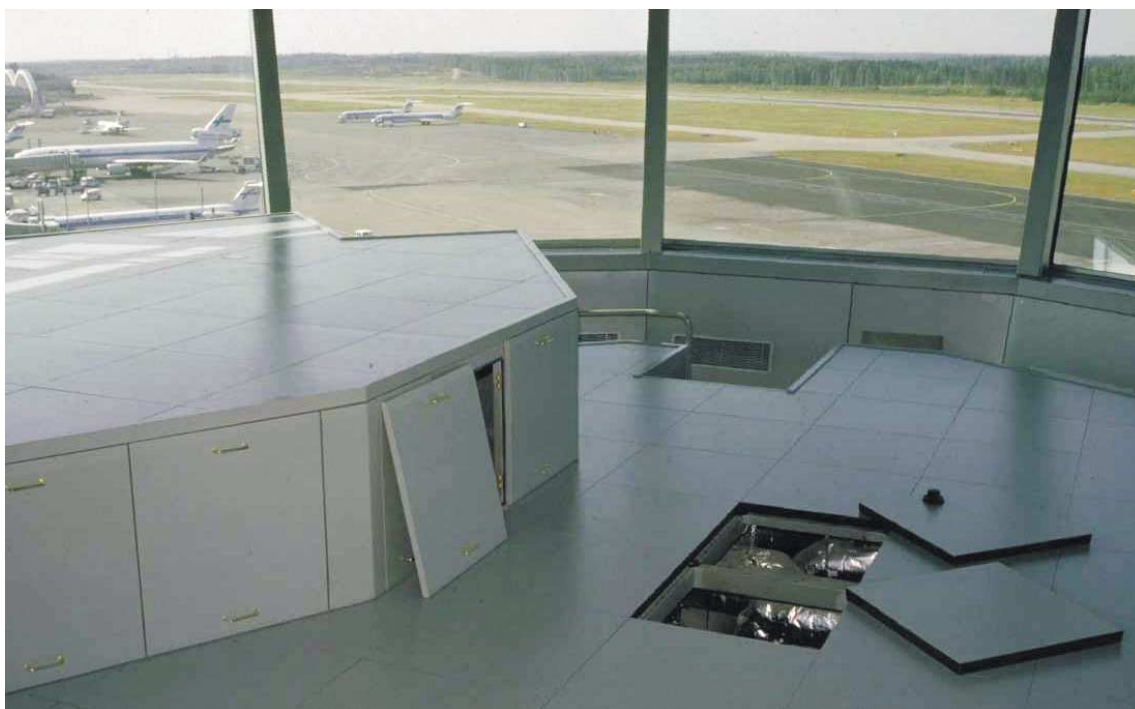
Helsinki-Vantaa flygfält, gålvkonstruktion av 37 mm cementspånskiva.
