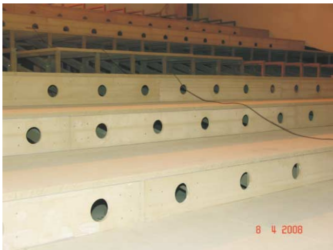
Finnkino Flamingo, gålvkonstruktion av 37 mm cementspånskiva.
