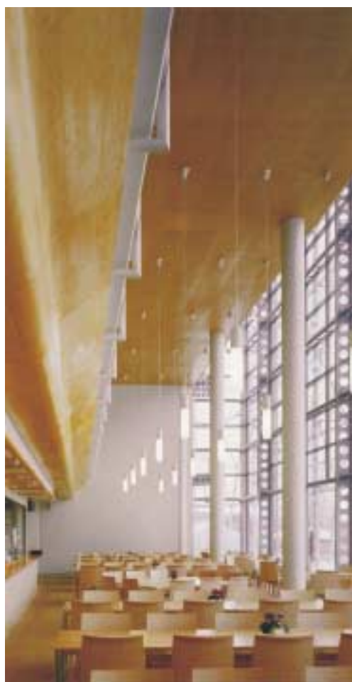
Biocenter Helsingfors, Elam perforerade och släta i kombination. Böjda Elam-paneler och exempel på rundad kant.
